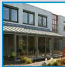
Ausweitung mit „Technikum“ im Nachbargebäude
